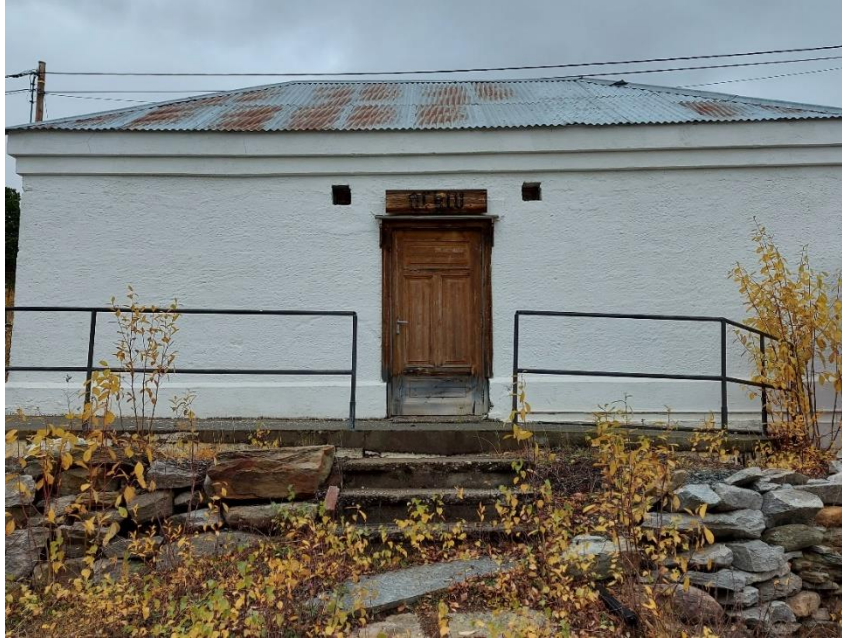
Mens de fleste bygningene omkring Folldal verk er trebygninger, er arkivbygningen brannsikkert bygget i mur.
